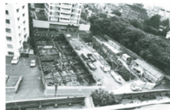
建設中の様子
