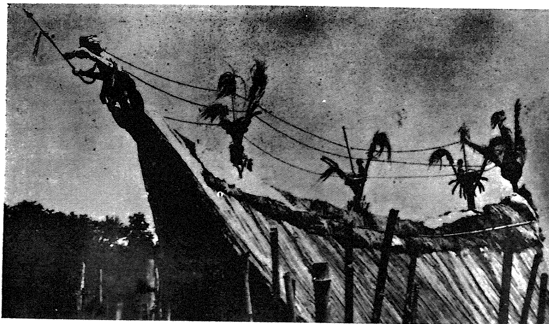
Abb. 15. Dach eines Grabschreins der Batak auf Sumatra (nach Bartlett). (S. 43.)
